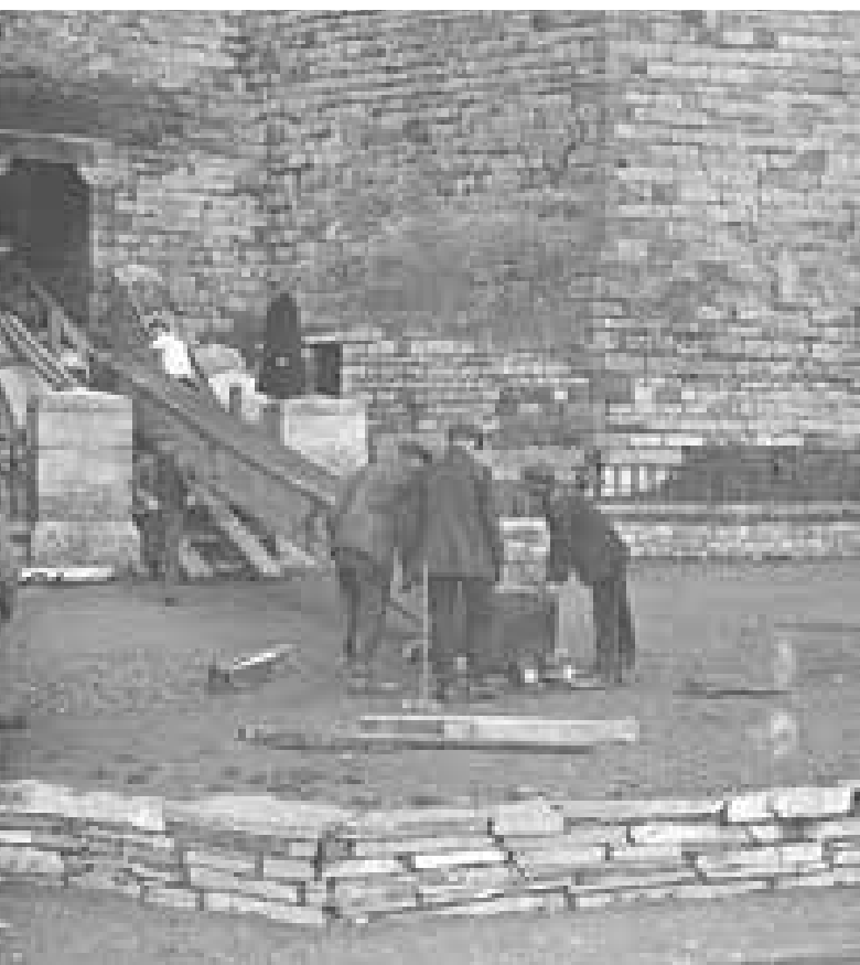
Gwaith adfer yng Nghaernarfon ar ddechrau'r ugeinfed ganrif. Yma, mae trawst derw enfawr yn cael ei gario i mewn i'r castell o'r cei, gan adleisio canrifoedd o arfer adeiladu.
